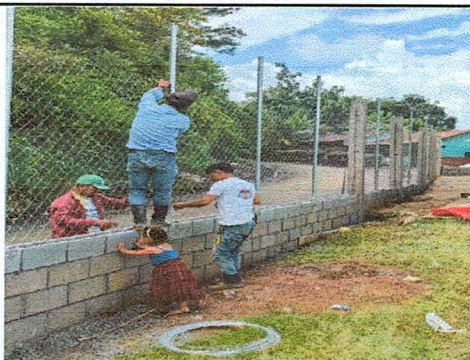
Foto 3: Colocación de maya.
